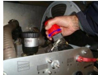
8 – Chiudere by-pass e dare pressione al naspo
